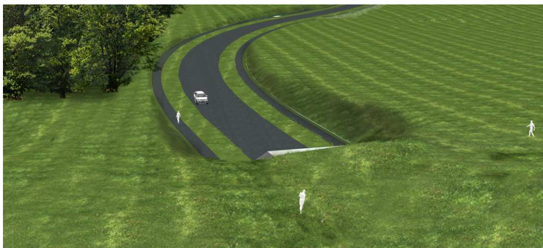
Figur 52. Tunneludmunding med mærkbart faldende/stigende terræn
