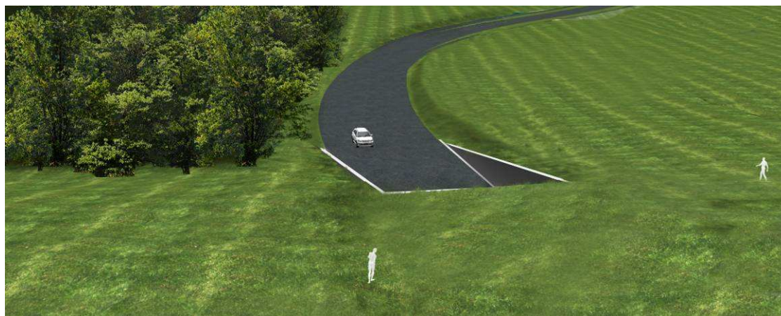
Figur 53. Tunneludmunding med støttemure
