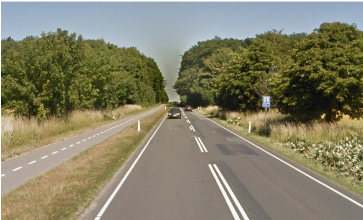
Figur 5, Eksempel på vejklasse 1: Trafikvej, gennemfartsvej i Svendborg Kommune – Nyborgvej. [©Google Maps]
