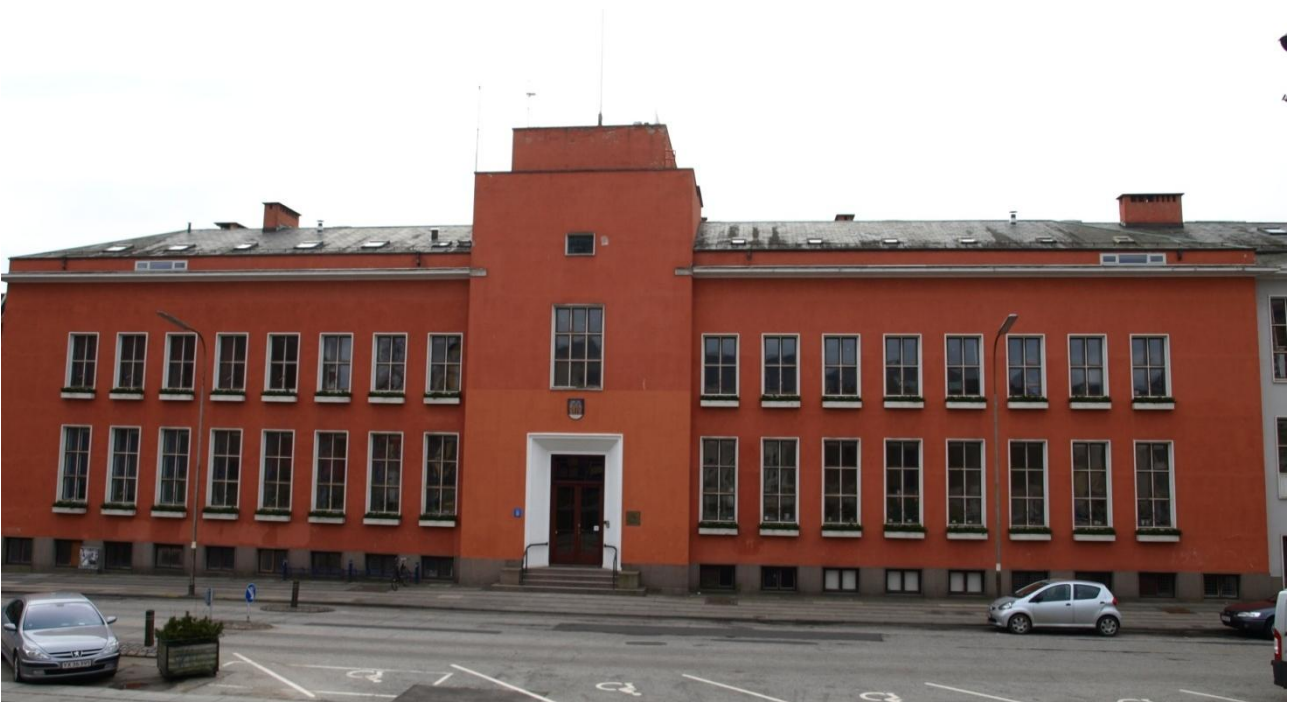
Svendborgs Rådhus fra 1939 er et fornemt eksempel på modernismens fortolkning af klassiske bygningsformer.
